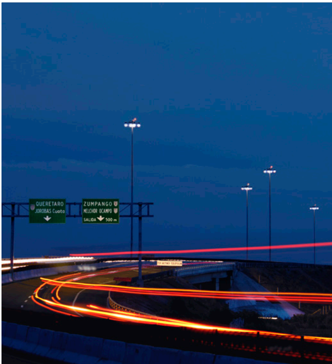
Circuito Exterior Mexiquense
